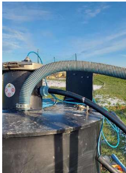
Tête de puits et équipements de collecte des gaz et de l'eau
